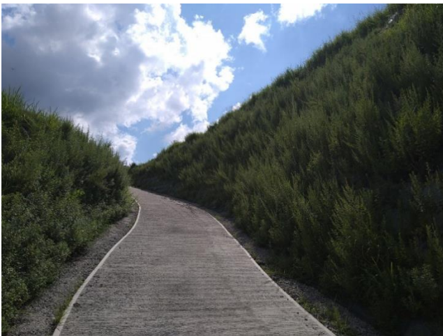
写真-3 施工後約 10 ヶ月 ヨモギとススキが繁茂
