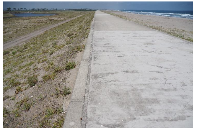
写真-5 施工7年後のCSG堤防の様子
