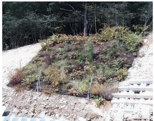
写真-1 西宮市の表土利用工 施工後6ヶ月（2002年10月）
