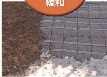
**モルタル袋** とアンカーピンの一体化構造により、植物の発芽生育に支障を与える凍上などの要因を緩和します。
