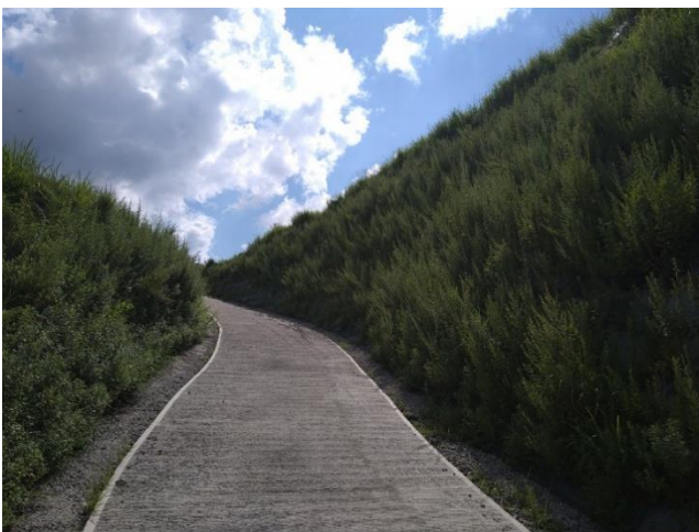
写真-3 施工後約 10 ヶ月 ヨモギとススキが繁茂
