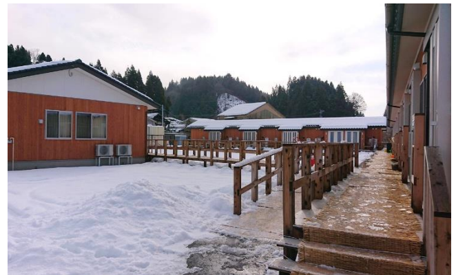
写真-1 輪島市三井地区のまちづくり型住宅
