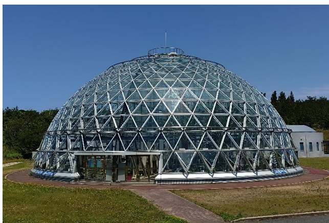
写真-2 乾地研のランドマーク、アリドーム。ガラス温室、つまり実験施設のため普段は外から眺めることしかできない。ただし夏季のオープンキャンパスでは中に入ることができる。良ければぜひ。
