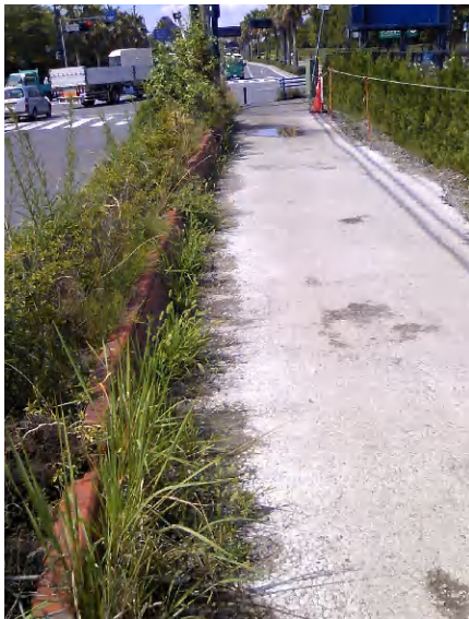
道路縦断方向樹木全景写真(幹傾斜状況) ※車道進行反対方向 (平成23年8月5日)
