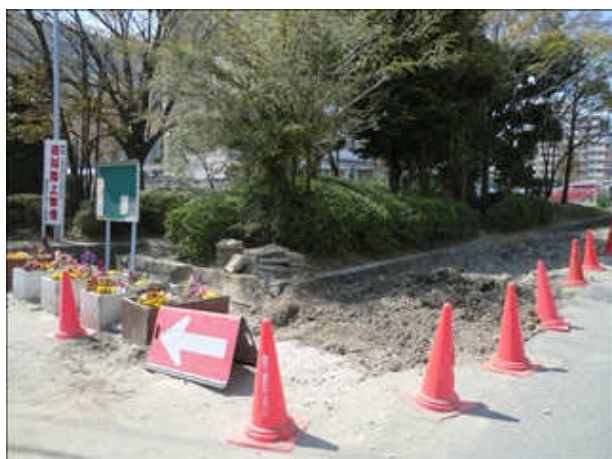
幹線道路に接する入り口部分。平板舗装箇所に噴砂が発生している。
