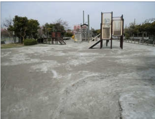
ダスト舗装、平板舗装箇所から噴砂している。
