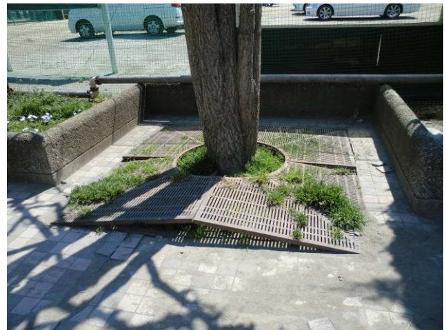
ツリーサークルの浮き上がり
