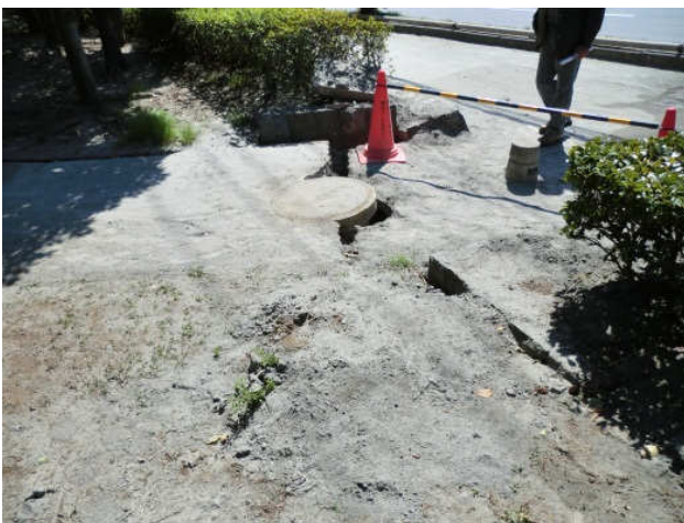
歩道部に亀裂が入り、噴砂している。
