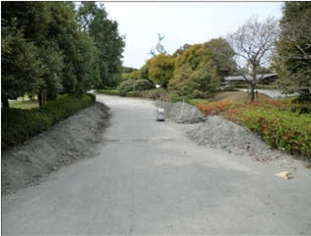
歩道、駐輪場から噴砂、歩道は沈下している。
