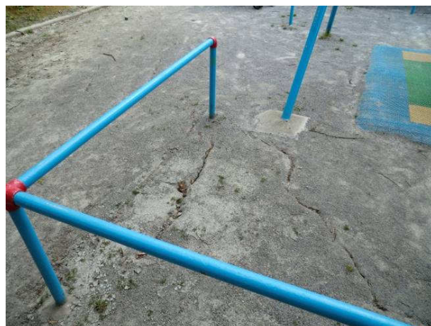
ダスト舗装箇所に噴砂口が認められ噴砂し、構造物基礎周辺に小クラックが認められる。
