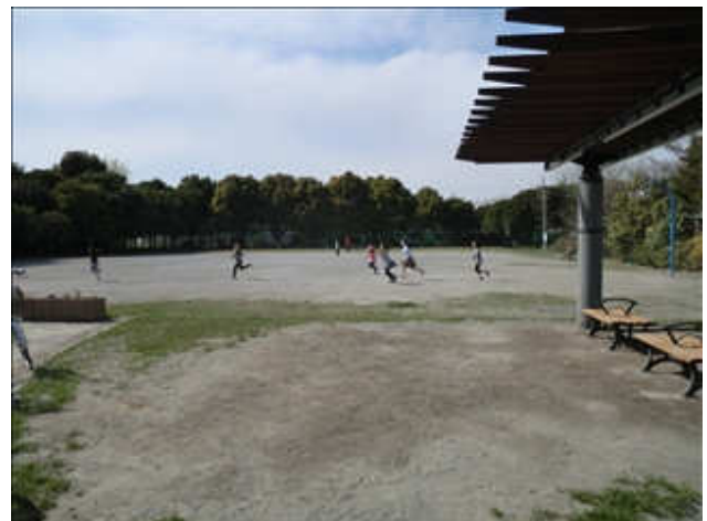
ダスト舗装とそれに接する芝地に噴砂が認められる。
