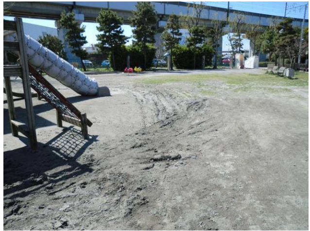
ダスト舗装箇所からの噴砂
