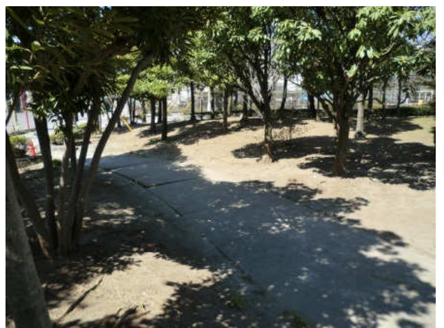
歩道部に亀裂が入り、噴砂している。
