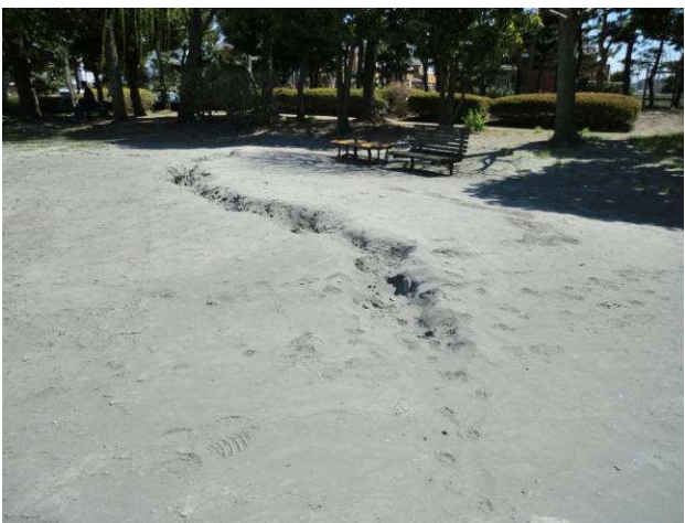
ダスト舗装に割れ目が入り噴砂している。
