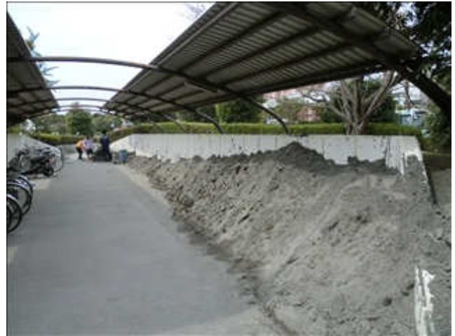
歩道、駐輪場から噴砂、歩道は沈下している。
