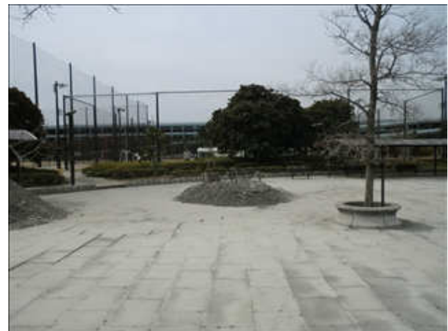
ダスト舗装、平板舗装箇所から噴砂している。
