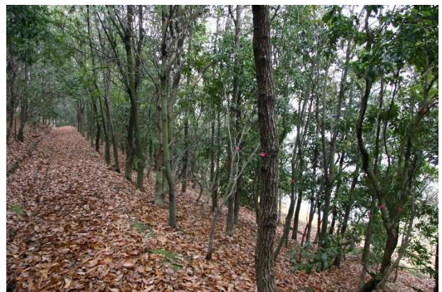
図-2. 施工後 13 年経過時点での植栽法面 (小宅ほか 2016)
