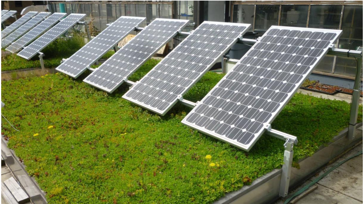
エコルーフの例3: グリーンインフラと他技術の組み合わせ (写真はソーラーパネルとの組み合わせ)
