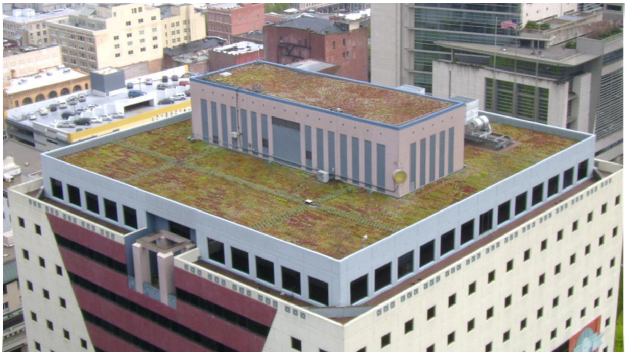
エコルーフの例2：ポートランドビルディング(改修工事)
