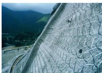
写真-2 厚層金網設置状況
