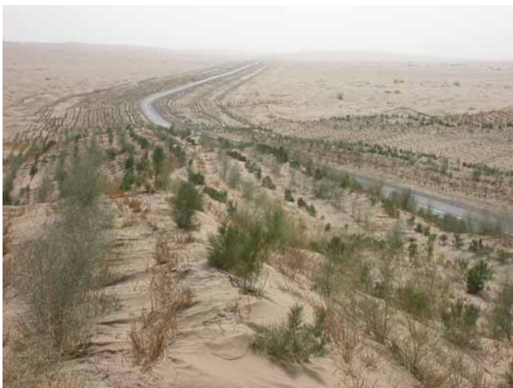
砂漠公路の緑化。草方格で砂の動きが沈静化すると、タリフ類や加力ノ類等を植栽してゆく。 (新疆ウイグル自治区輪台～民豊 2004.10.12 撮影)
