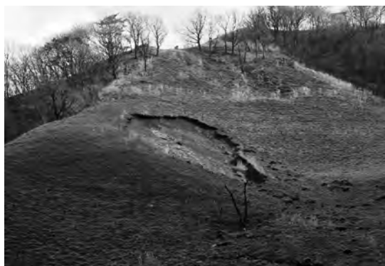
写真-1 阿蘇ススキ草原における斜面崩壊地
