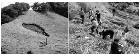
図-4 左：対象牧野の崩壊地，右：2017年8月の修復作業
