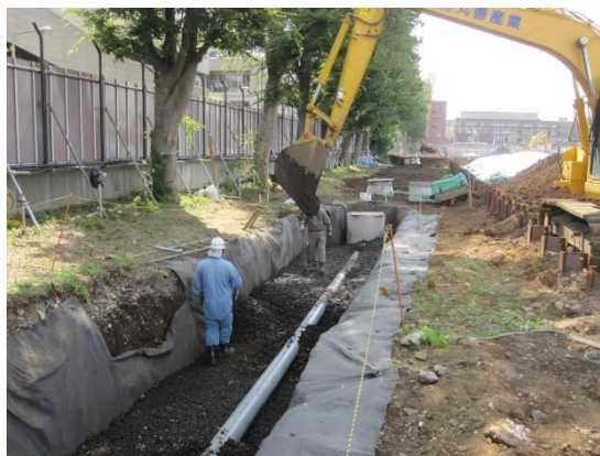
写真5 貯留槽に根を誘引する手法
