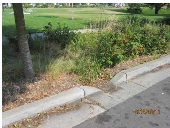
写真 2 道路から雨水が流れ込むよう工夫された縁石
