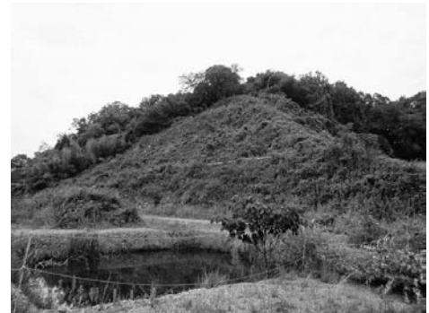
写真-1 表土利用工 施工後3年9ヶ月（平成30年9月）
