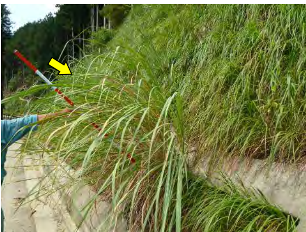
ダム建設内の法面に生育するヨシススキ（2014/9 月福岡）
