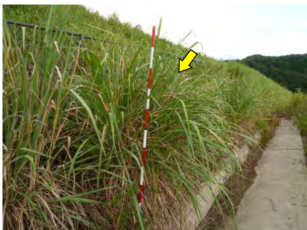
ダム建設内の法面に生育するヨシススキ（2013/9 月鳥取）
